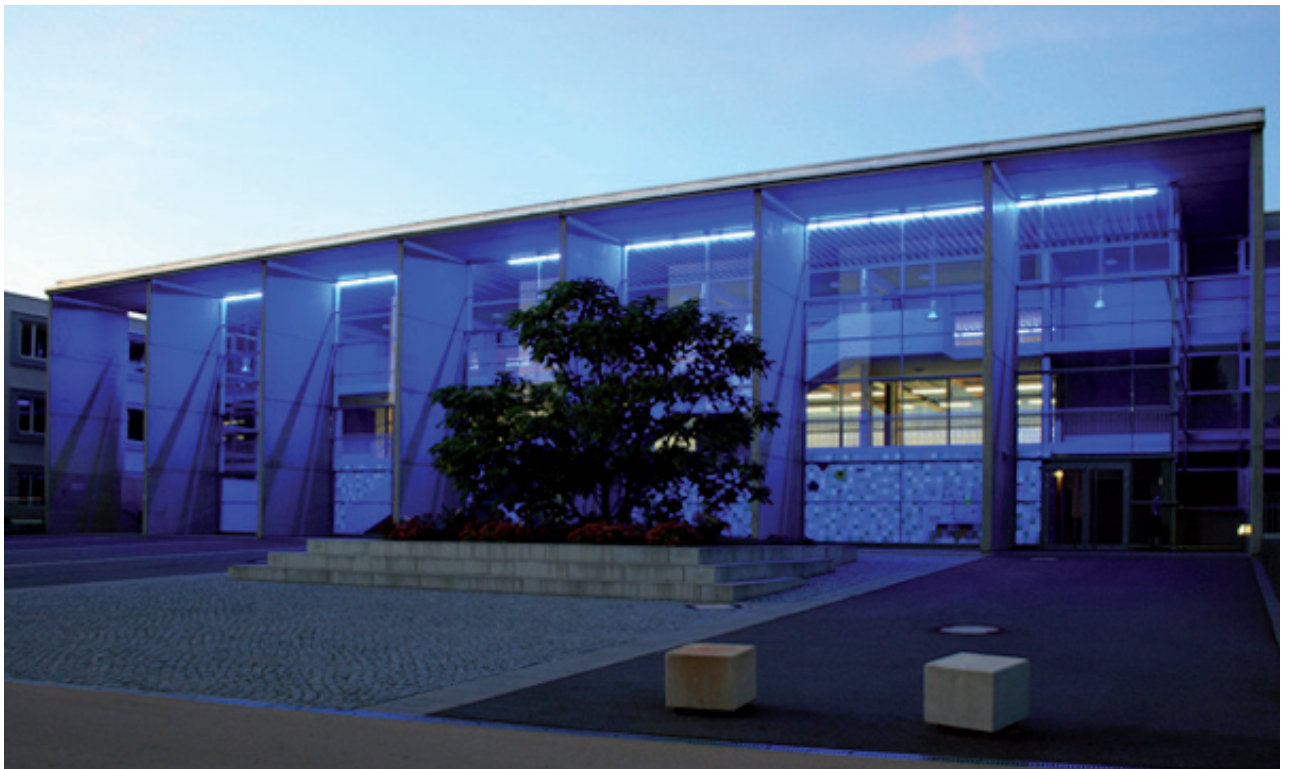
Rekonstruktion der 8. Gesamtschule mit Aula und Sporthalle zur Sachsendorfer Oberschule
