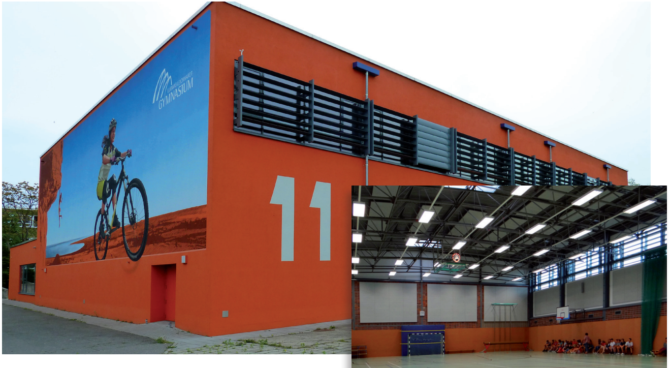
Ludwig-Leichhardt-Gymnasium Cottbus Umbau und Modernisierung der Multifunktionshalle mit Sporthallenfunktion
